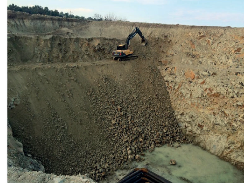
► HES Yükleme Havuzu Harfiyat ve İnşaat İşleri
