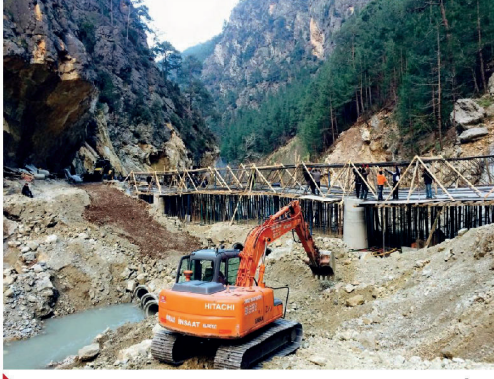
► Karaisalı Yer Köprü ve Yol Yapım İşi
