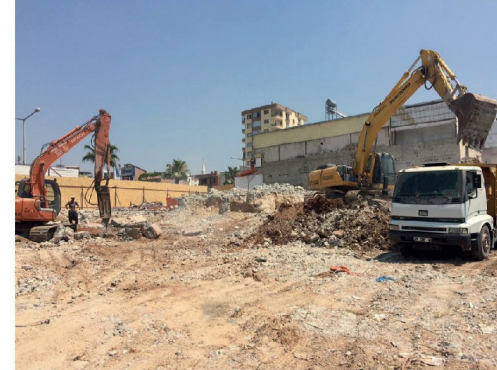
► Okul ve Lojman Yıkım İşleri
