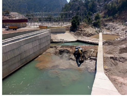
► HES Silt Temizliği
