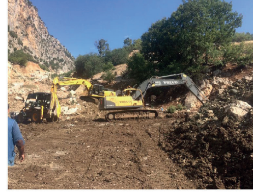
► HES Tahliye Kanalı Yapım İşİ
