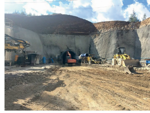
► HES Tünelindeki İnvirt Beton Kırımı ve Tamirat İşleri
