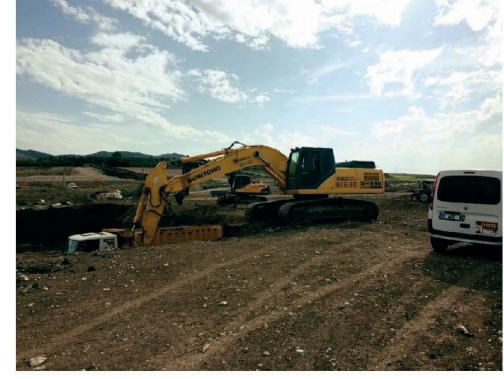
► Bina Temel Açma ve Harfiyat İşleri
