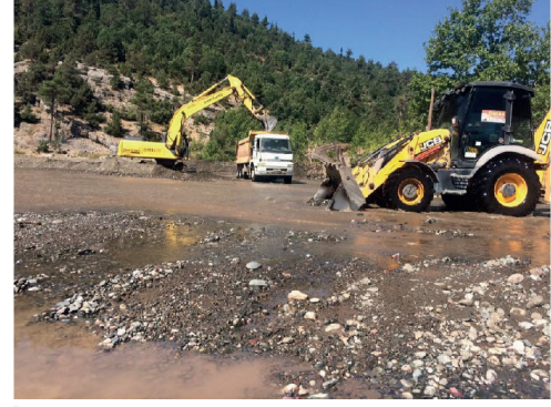
► HES Regülatör Mansap ve Silt Temizliği
