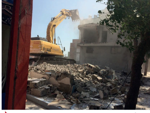
► Kentsel Dönüşüm ve Toplu Yıkım İşleri
